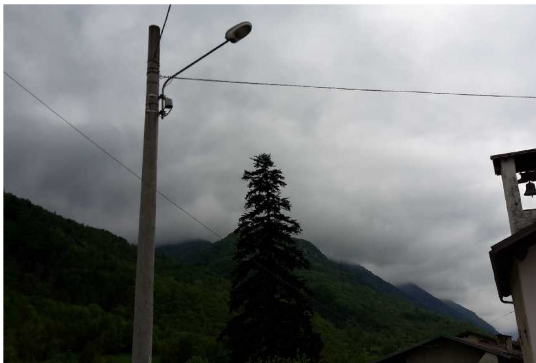
Fig. 1.1 - Sostegno esistente in prossimità di Borgata Paluch.
